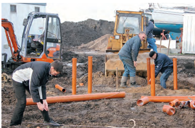
Wolfgang Ewert (Mi.) mit Drachenbootpaddlern beim Verlegen der Schutzrohre für den Sanitäranbau.
