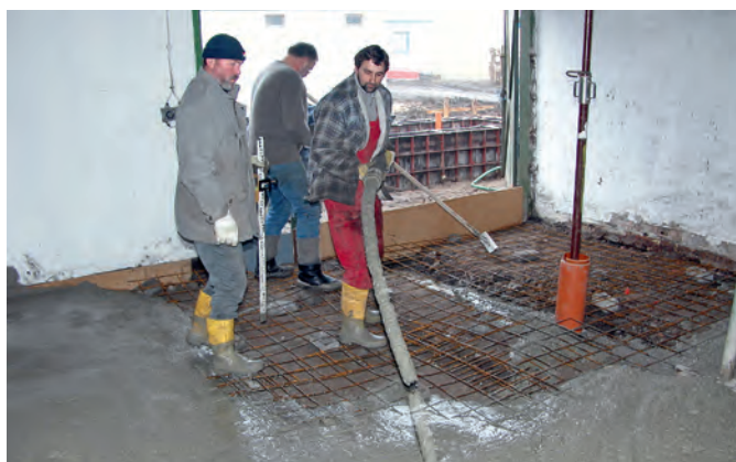
Konrad Schulz, Wolfgang Ewert und Dirk Müller (v.li.) beim Schütten des Betons im Sanitäranbau.
